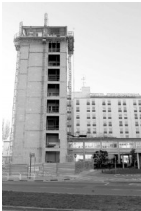
Obra de incorporación de escalera de evacuación a la Clínica Universitaria (Universidad de Navarra).
