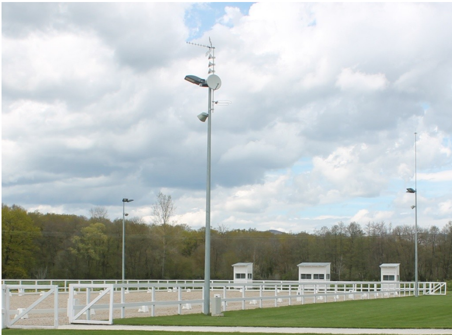
Antena integrada en un foco para la iluminación de una pista exterior. Arqto. Patxi Mangado.
